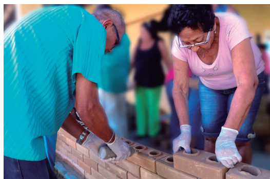
Aula prática de construção utilizando técnicas de edificações sustentáveis e tijolos ecológicos.
