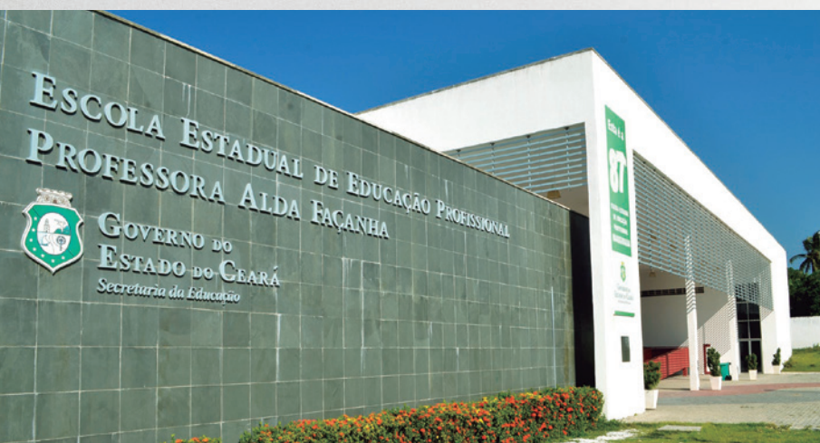
Fachada da Escola Estadual de Educação Profissional Professora Alda Façanha Facade of the State School for Vocational Education Teacher Alda Façanha
